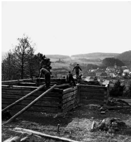
Montáž objektu rolnické usedlosti přeneseného z Velkých Karlovic, údolí Miloňov do areálu Valašské dědiny Valašského muzea v přírodě v Rožnově pod Radhoštěm. 60. léta 20. století, fotoarchiv Valašského muzea v přírodě v Rožnově pod Radhoštěm.
