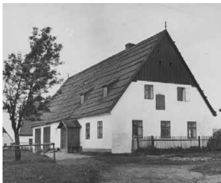
Dům se štítem vyzděným do poloviny, závětrím a doškovou střechou s tyčemi. Typické stavení pro dnes již neexistující obec Habartice na Teplícku. Nedatováno, Muzeum města Ústí nad Labem.
