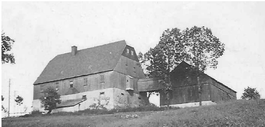
Dnes již nestojící usedlost č. p. 28 v Českém Jiřetíně s arkýřovým záchodem a můstkem spojujícím stodolu a obytnou část. 1943, foto Seifert, Oblastní muzeum v Mostě.
