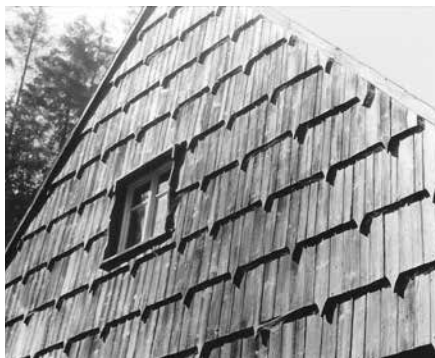
Okno s orámováním v šindelovém štítě č. p. 128 v Českém Jiřetíně. Střídající se rovné a zašpičatělé ukončení šindelů je jedním z mnoha vzorů šindelového obložení štítů. 1983, Oblastní muzeum v Mostě.
